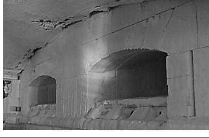
Şekil 1-2 Ç/H Kanal taşı aşınmaları
