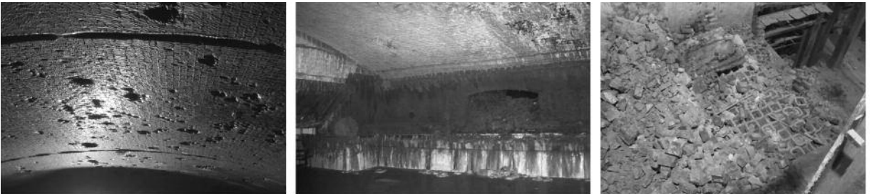
Şekil 7. Petrokokun bir fırının kemer, üstyapı ve rejeneratör dolguları üstüne etkileri
